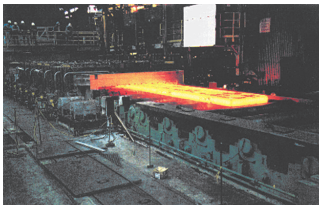
Общий вид индукционной установки для подогрева слэбов мощностью 42 МВт на заводе Geneva Steel (Utah, USA)
