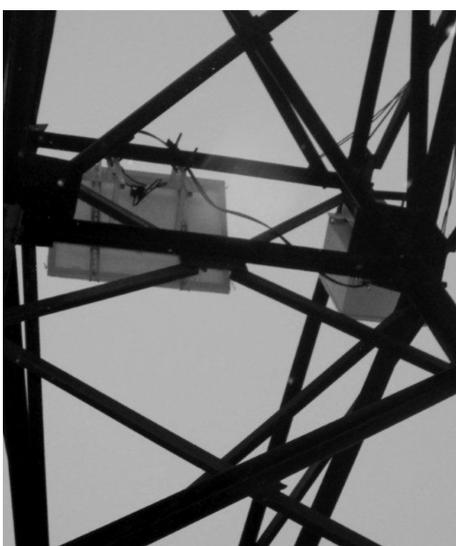
Рис. 5. Варианты установки шкафа с элементами комплекса на опорах ВЛ
